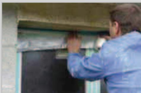
Découper la bande à la dimension de la fenêtre, et la coller en place avec la partie adhésive.
